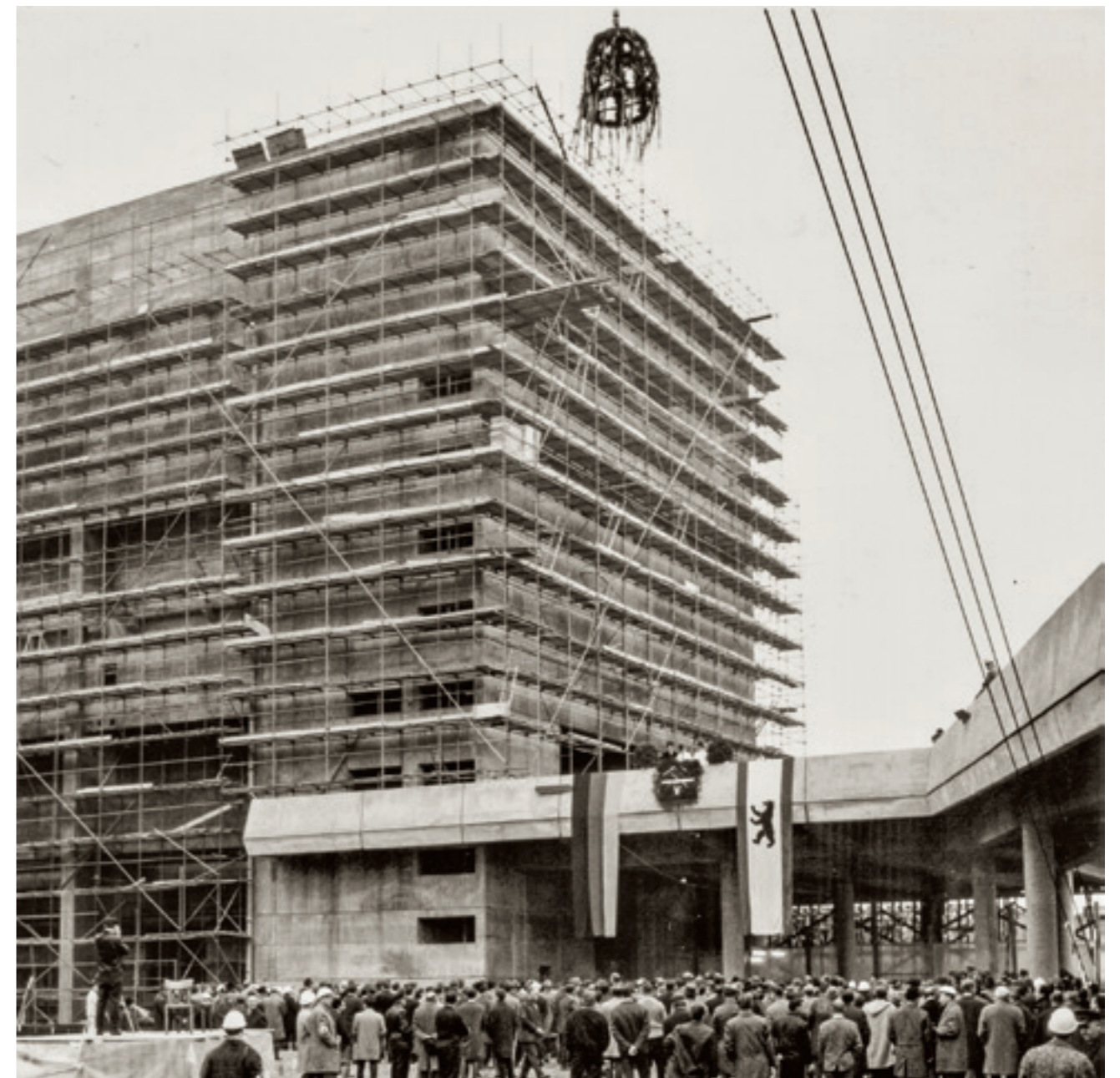
Richtfest am Müllheizkraftwerk
