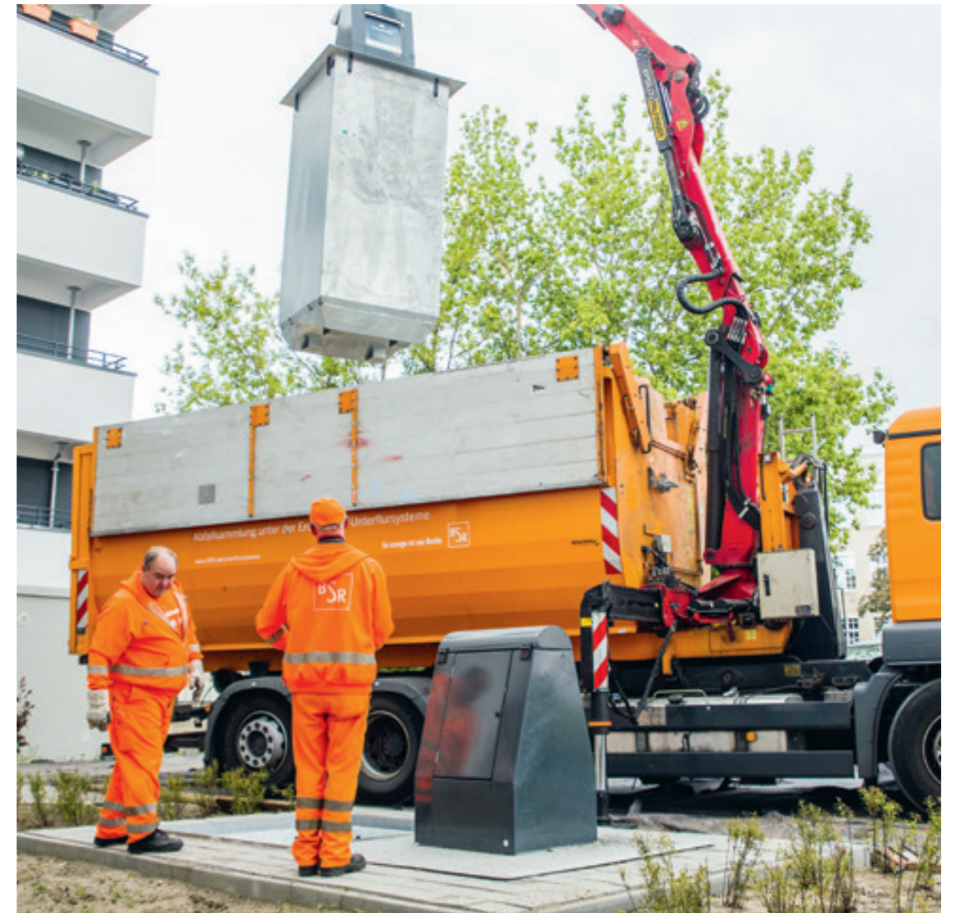
Unterflurbehälter bei der Entleerung
